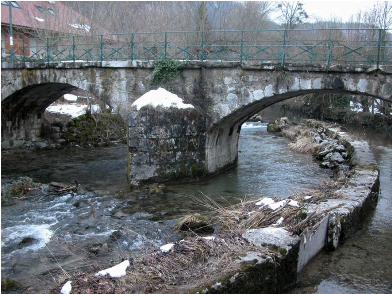
Vue générale depuis l'aval avec canal d'aménée d'eau.
