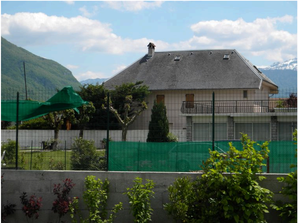
Façade nord d'une ancienne ferme isolée près du lac. (2008 A3 383)
