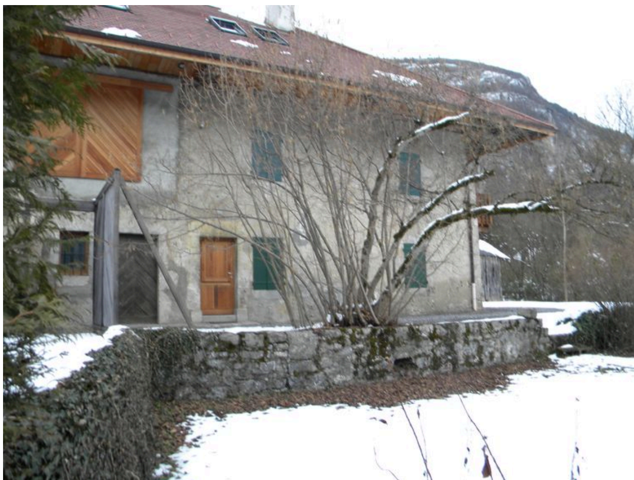
Vue de la façade sud-ouest avec partie habitation.
