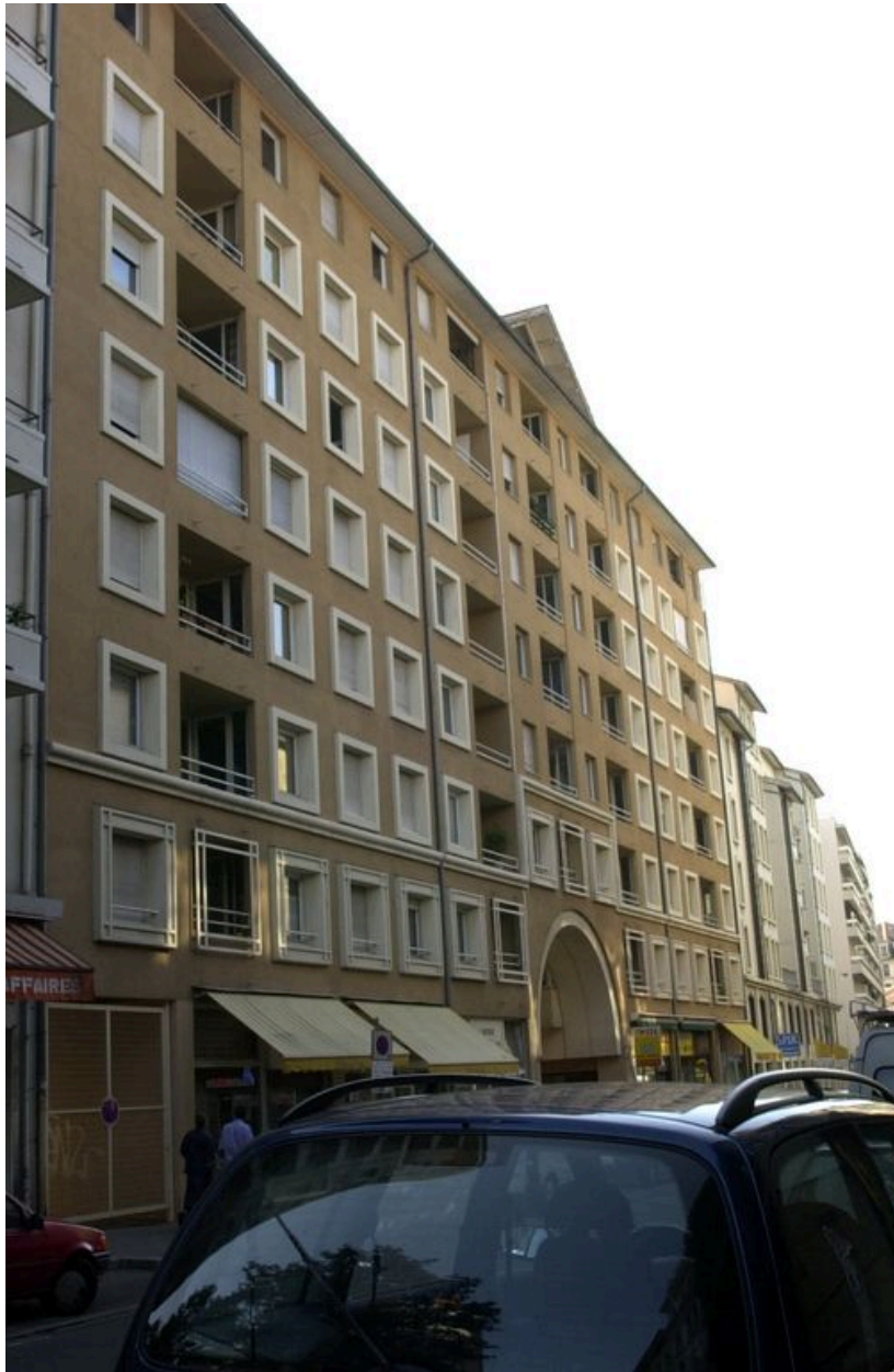
Elévation principale depuis le sud-ouest
