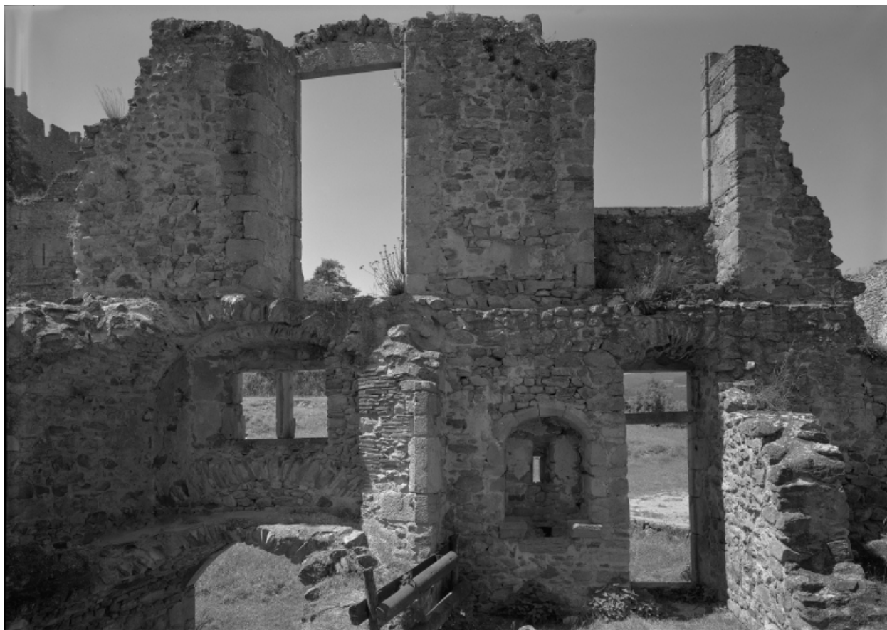
Premier baile, partie nord-est : vue intérieure du premier ouvrage d'entrée, du nord.
