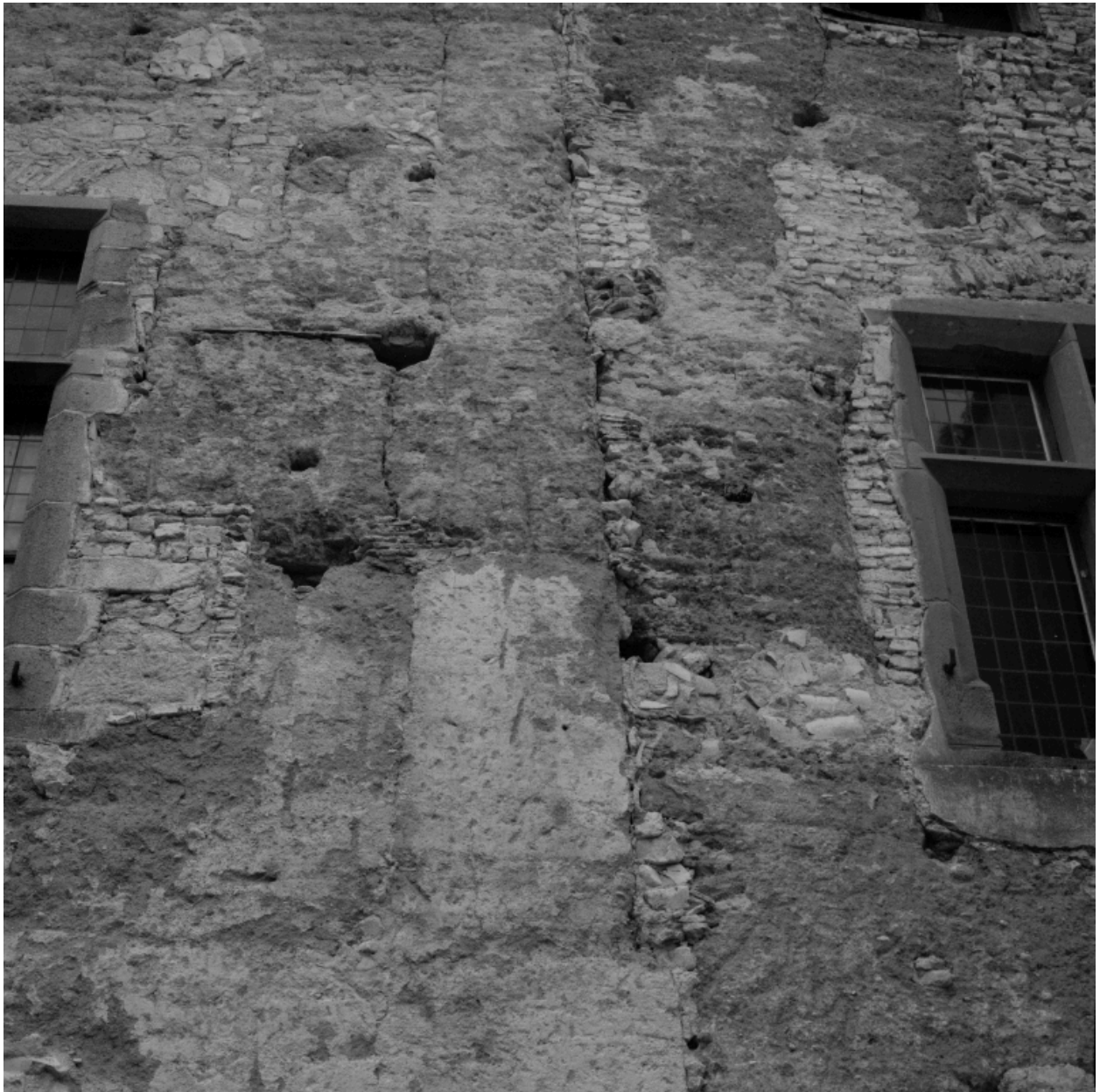
Façade sur jardin du corps de galerie après décroûtage, partie sud accotée au corps primitif en pisé : détail de la reprise.
