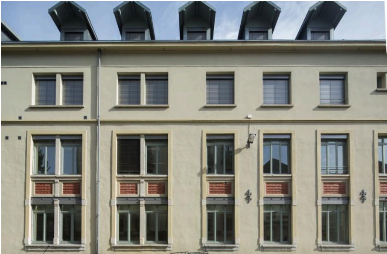
Aile Marcoz, détail de la façade, reprise 2011.
