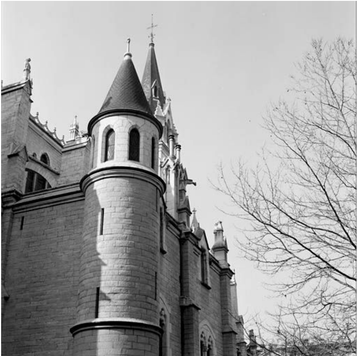
Élévation nord : vue partielle située au-dessus de la chapelle de semaine
