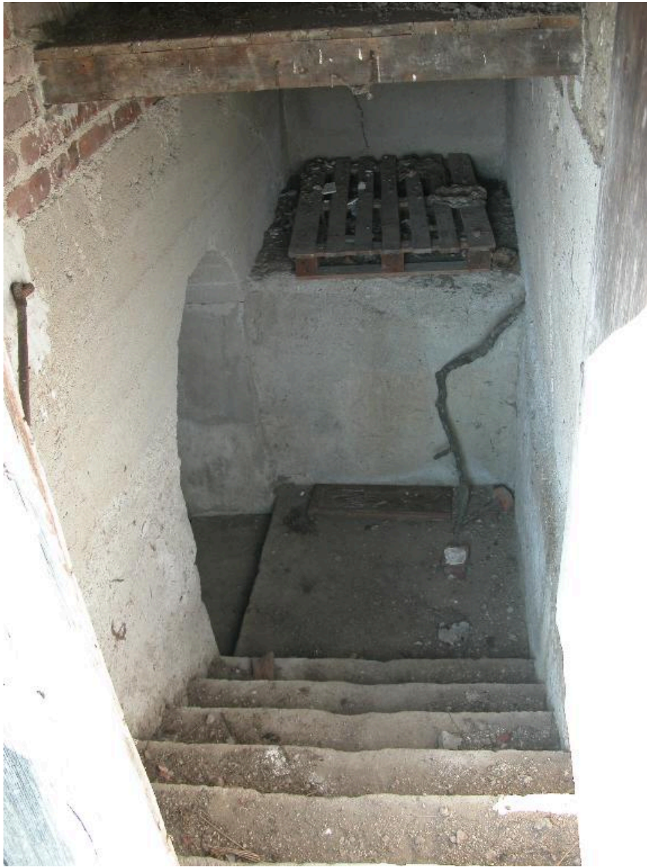
Vue intérieure de l'escalier droit descendant au sous-sol.
