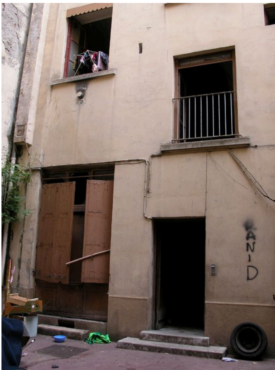
Elévation postérieure sur cour : l'arrière de la boutique occupée par une droguerie
