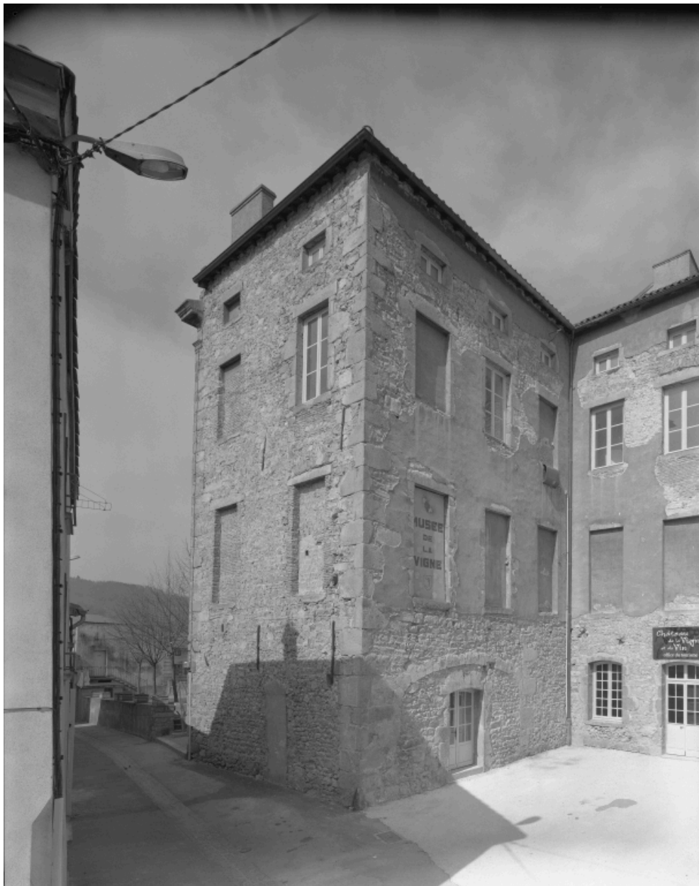
Vue du pavillon sud depuis la rue des Martyrs de Vingré, du nord.
