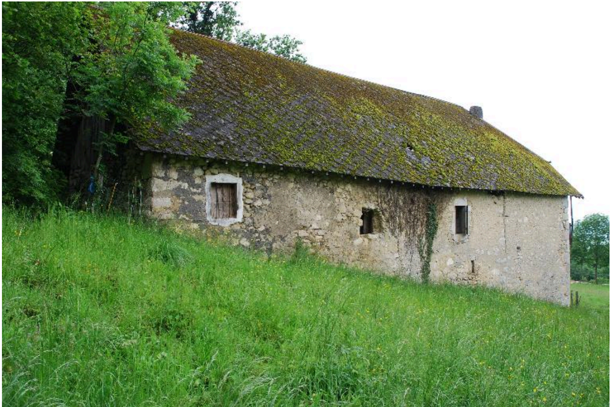
Vue d'ensemble de la façade latérale arrière.
