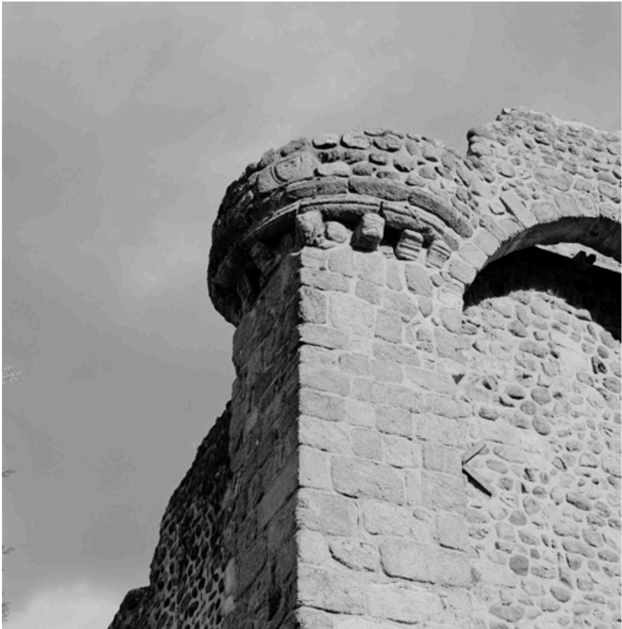
Détail des vestiges de la tourelle en échauguette de l'angle nord-ouest des bâtiments conventuels, depuis l'ouest.
