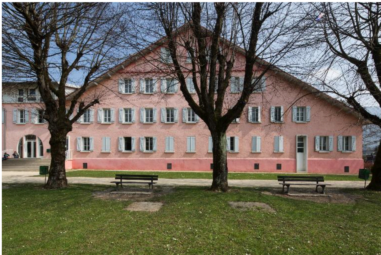
Bât. A : façade ouest de l'aile ouest
