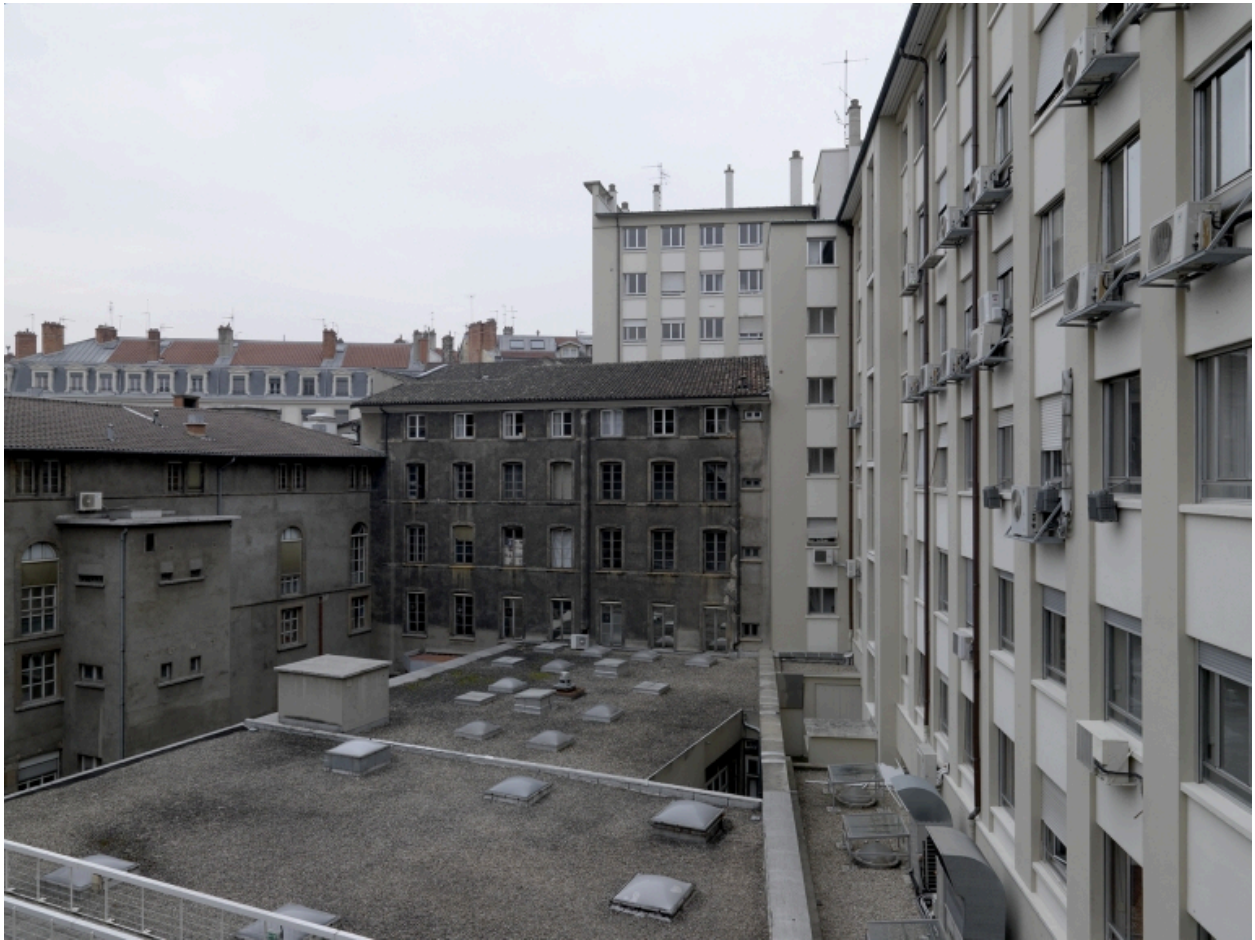
Bâtiment S nord. Façade est sur la cour du Magasin
