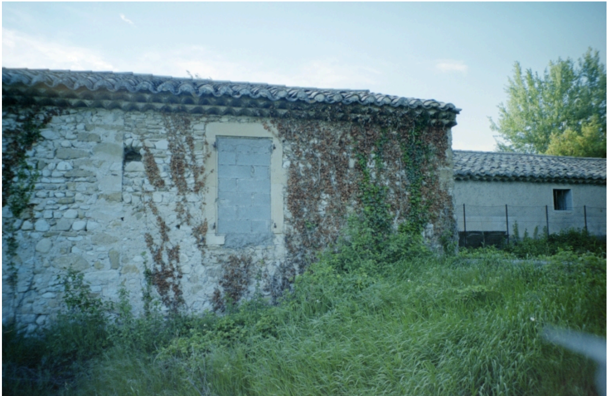
Vue partielle des élévations postérieures ; à droite, le bassin de retenue.
