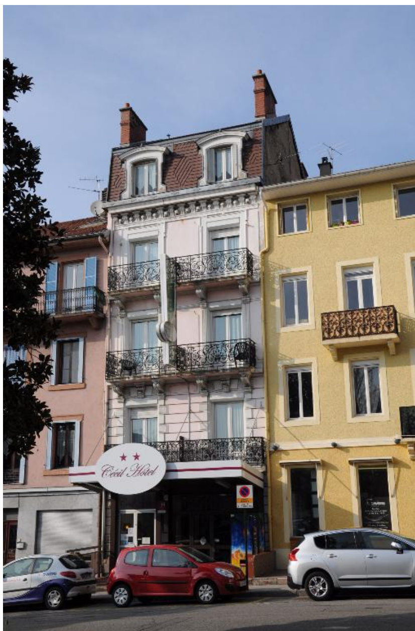
Elévation sud, sur l'avenue Victoria
