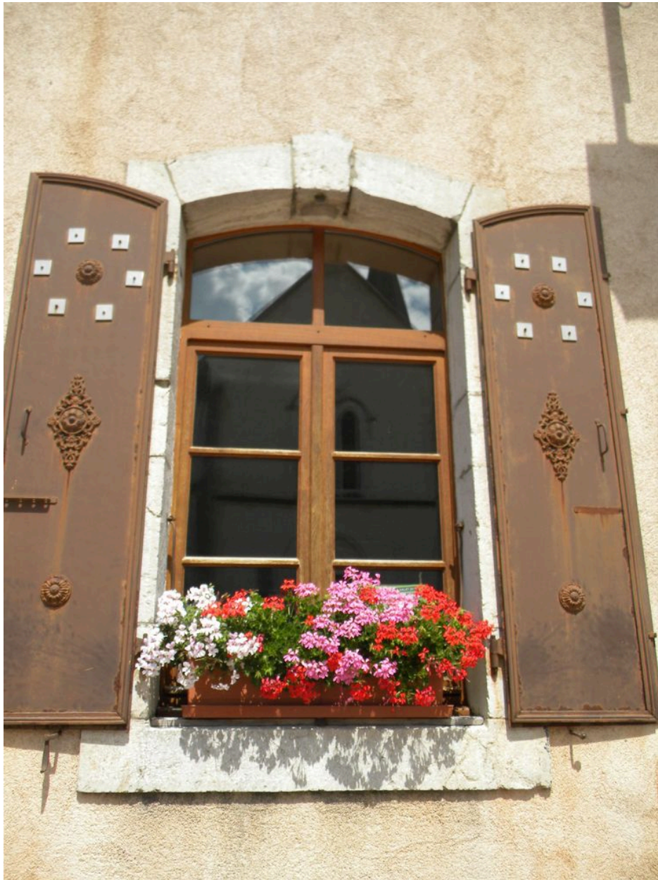
Détail d'une fenêtre du rez-de-chaussée sud.
