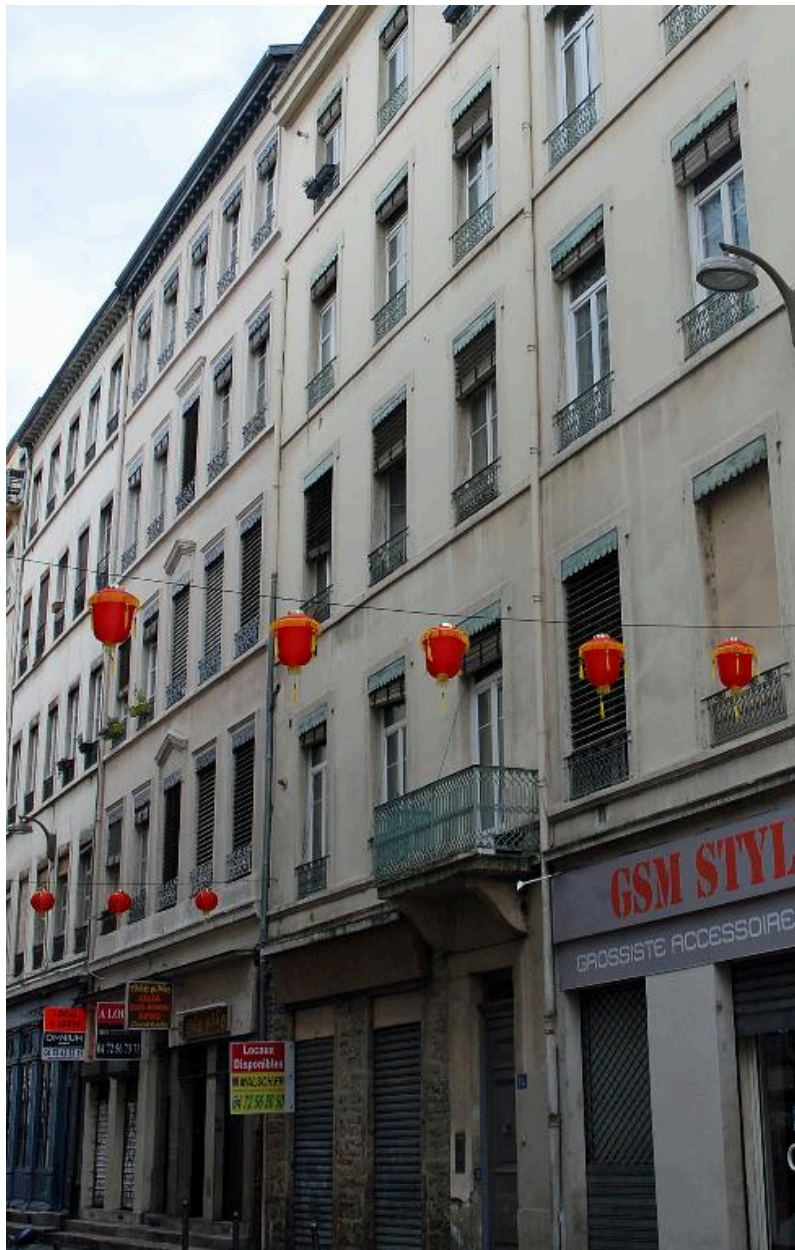
Immeuble sur rue, vue générale
