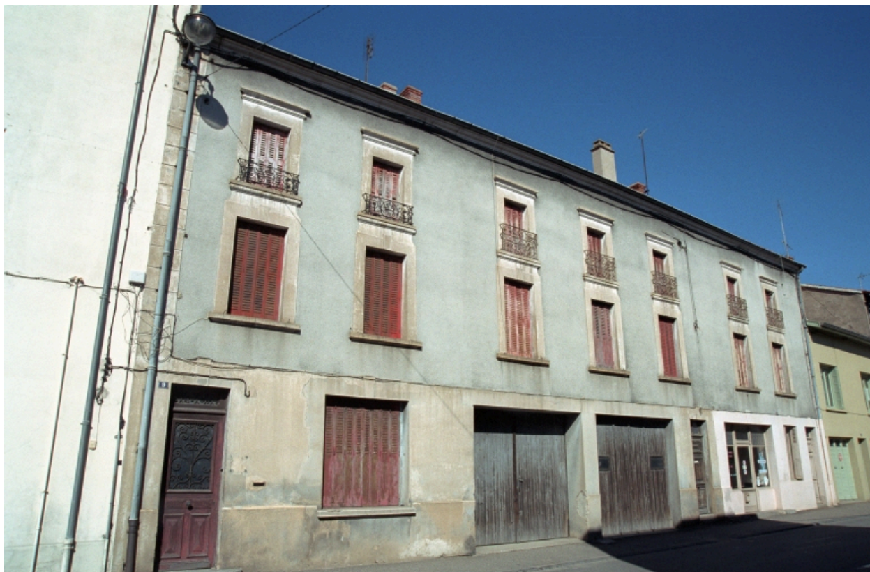
Boën, îlot 11, Clermont (rue de) 9, 11, 13. Vue générale des façades sur rue.
