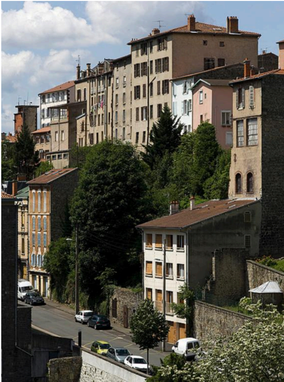
Exemple de bâti perpendiculaire à la pente, avenue Pierre-Guérin et rue de Lyon.
