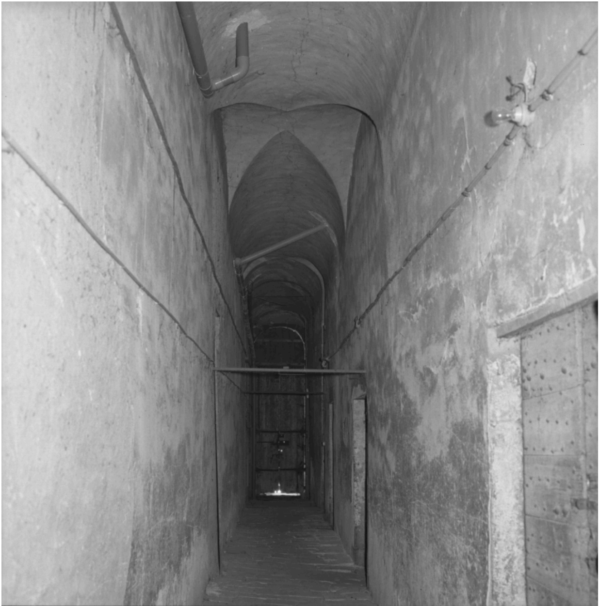
Etage de soubassement : couloir longitudinal médian.
