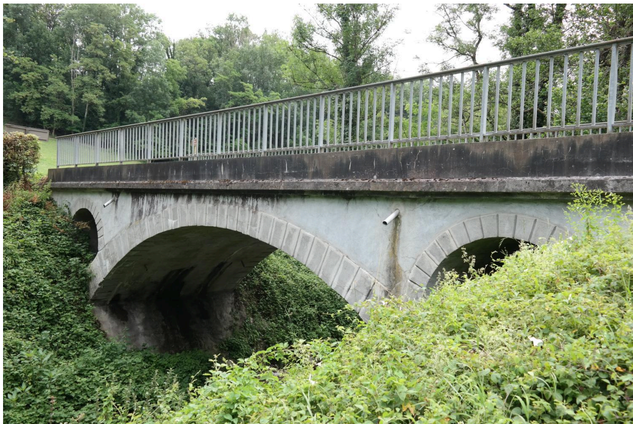
Pont du Châtelard, vue de la face amont
