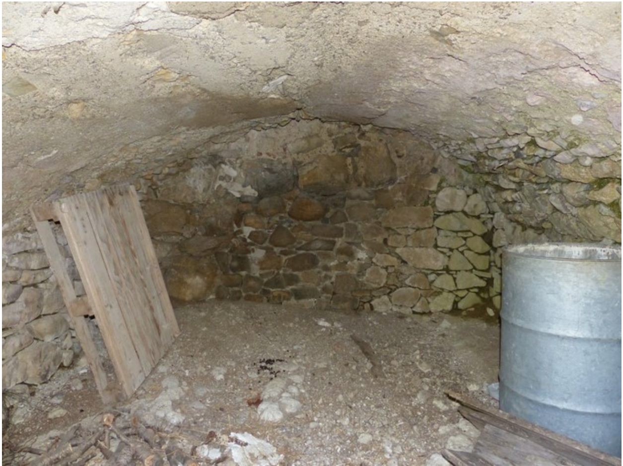
Partie sud-est. Premier étage de soubassement, resserie. Vue de volume prise du sud.
