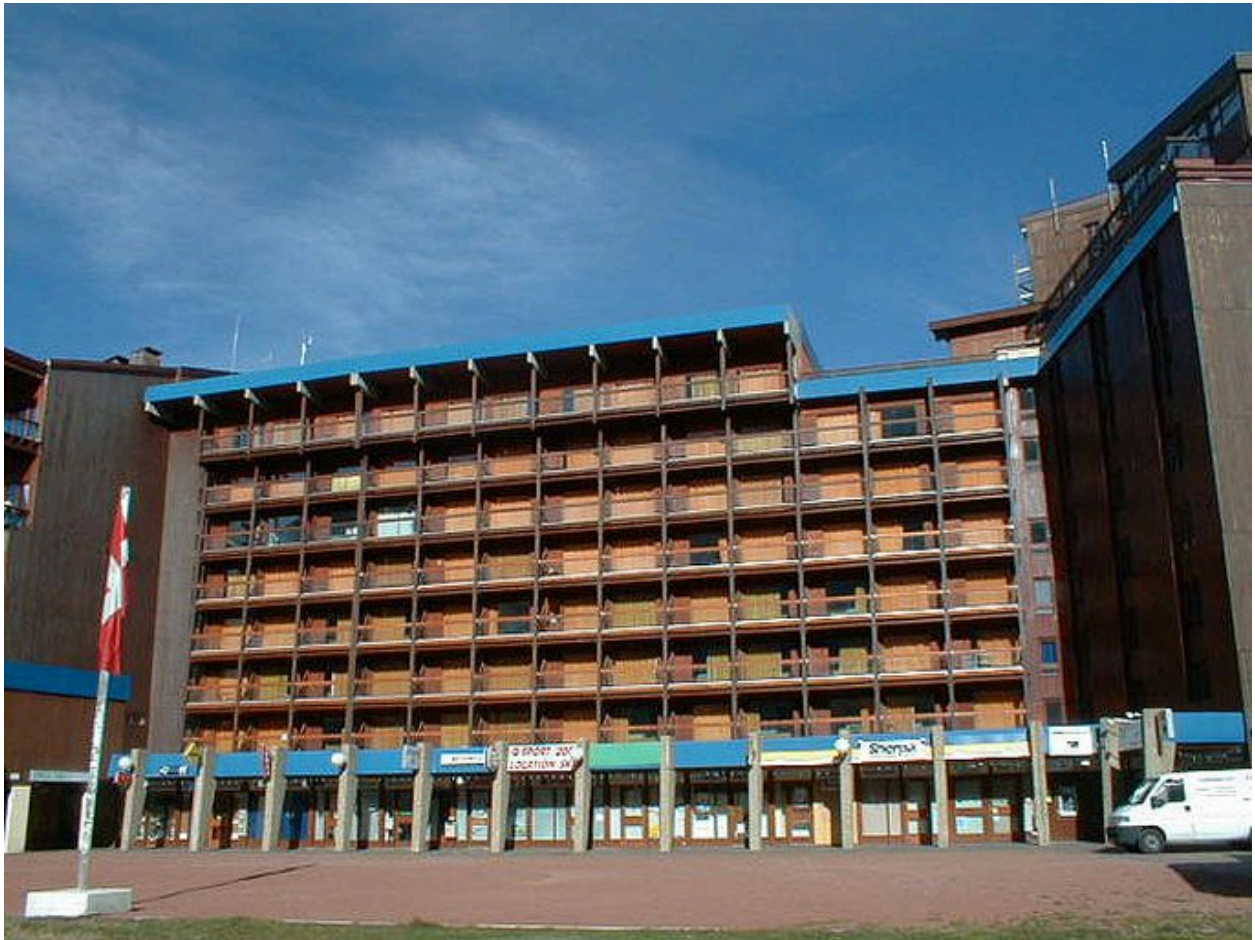
Façade sud-est, place du Ski
