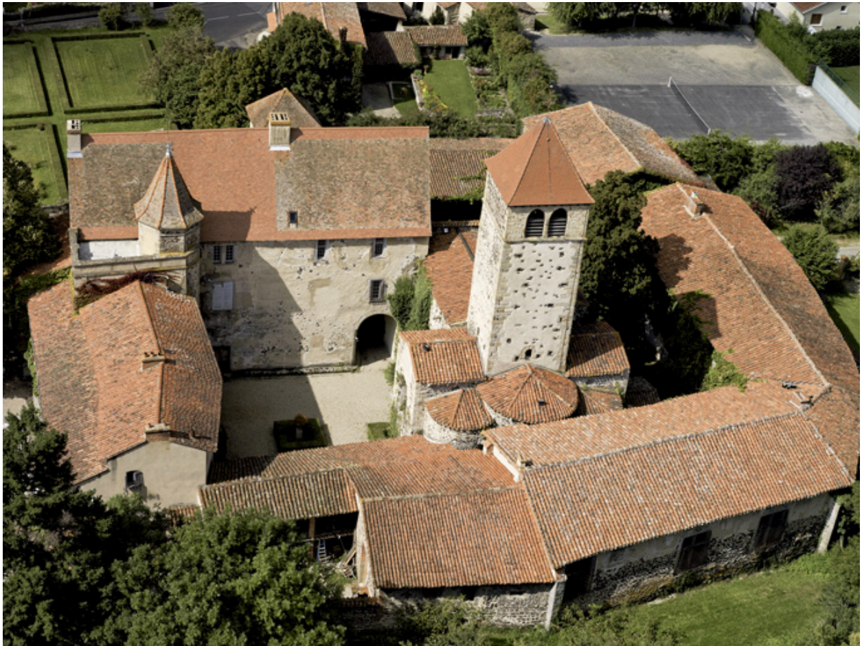
Vue d'ensemble aérienne depuis l'est.
