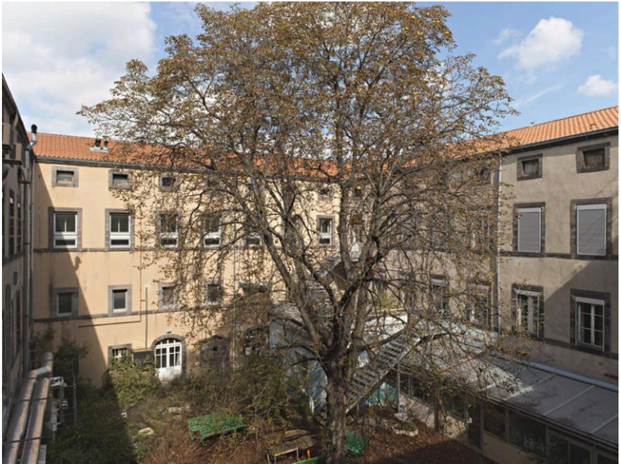
Hôtel-Dieu de Clermont-Ferrand. Le Refuge, cour intérieure vue du sud-ouest.
