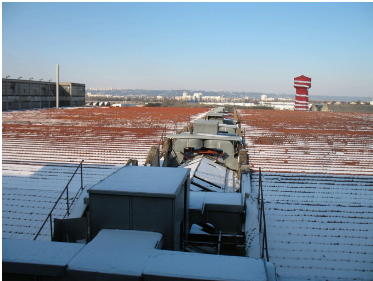
Vue d'ensemble des toits : colonne technique
