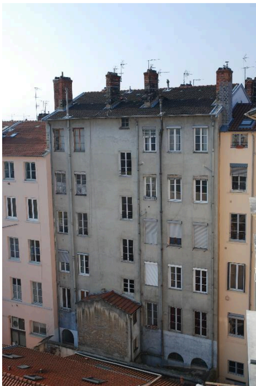
Vue générale de l'élévation postérieure
