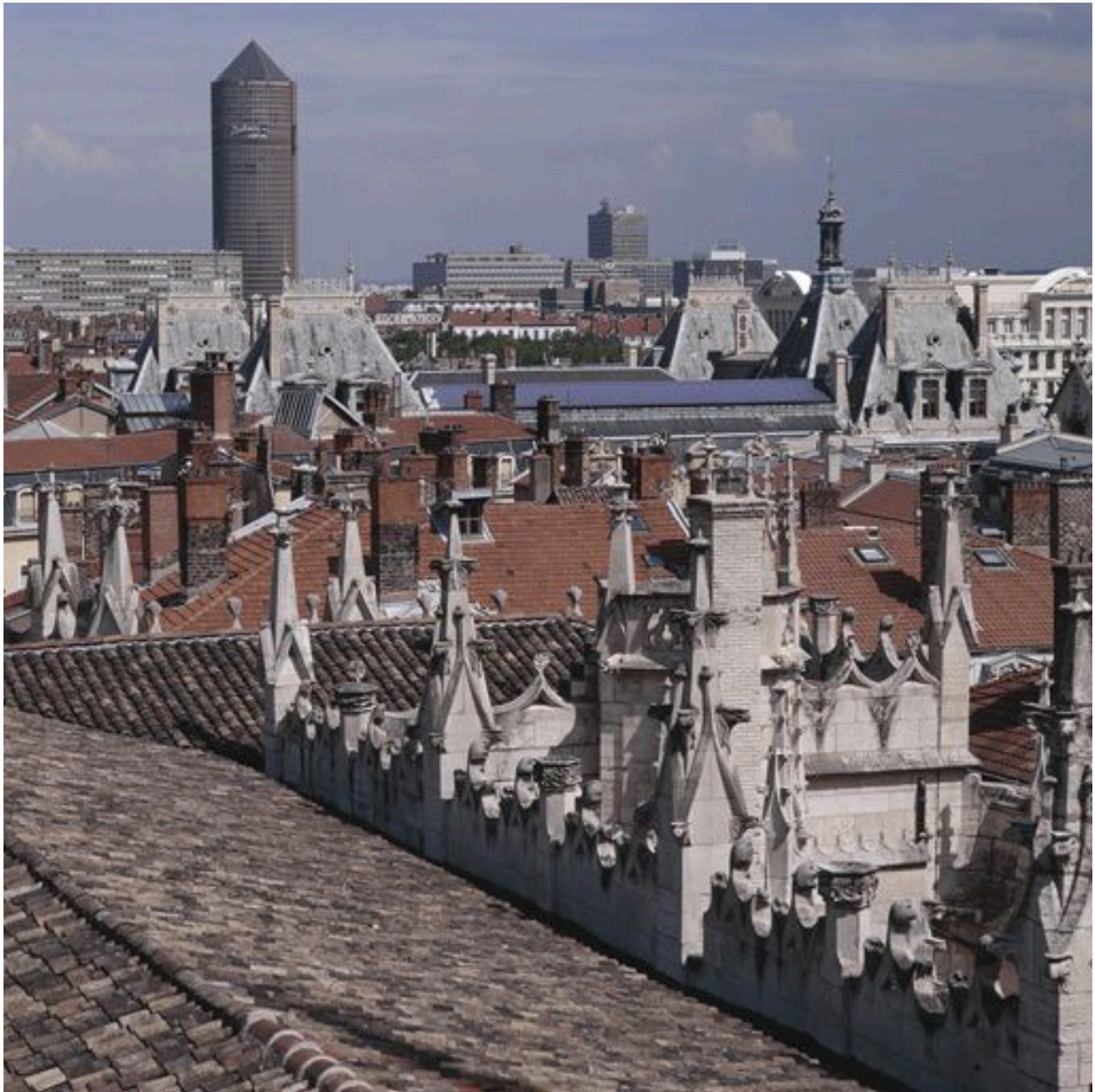
Toit du vaisseau central de la nef et du bras sud du transept
