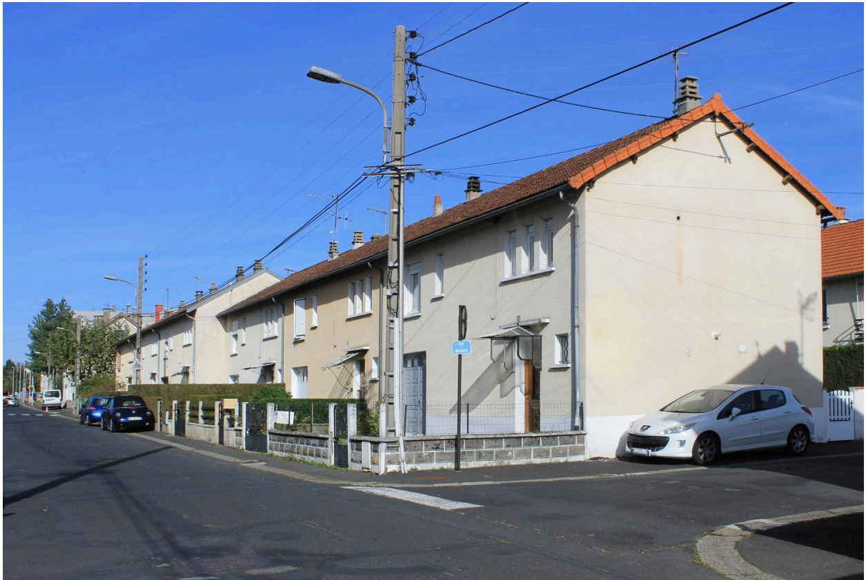
Aurillac, cité des Camisières, maisons type « Habitations à loyer réduit », n° 7 à 15 rue de la Cère et carrefour de la rue du Mars.
