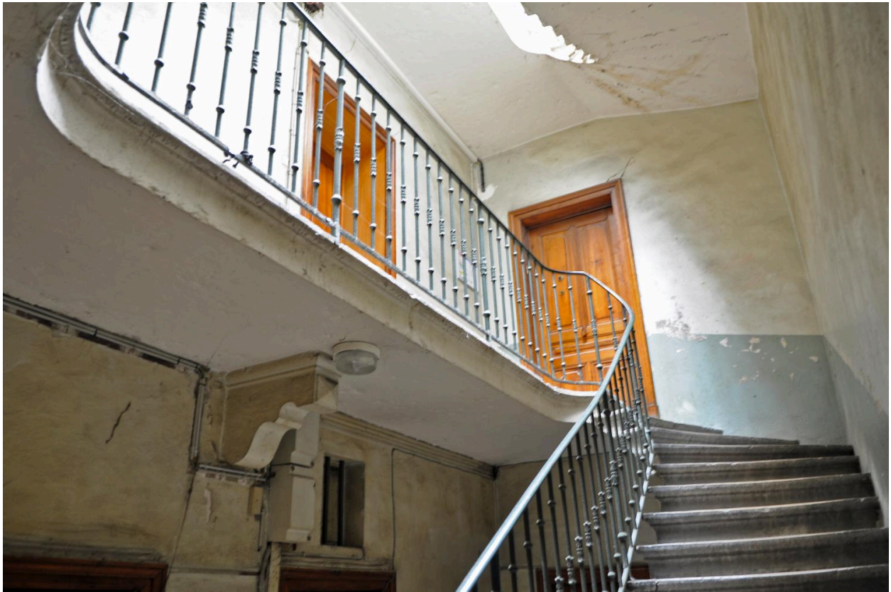
Bâtiment sur cour, un palier de l'escalier
