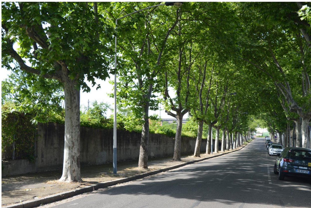
Mur d'enceinte de l'usine Véninov - Boulevard Laurent Gérin - mai 2022
