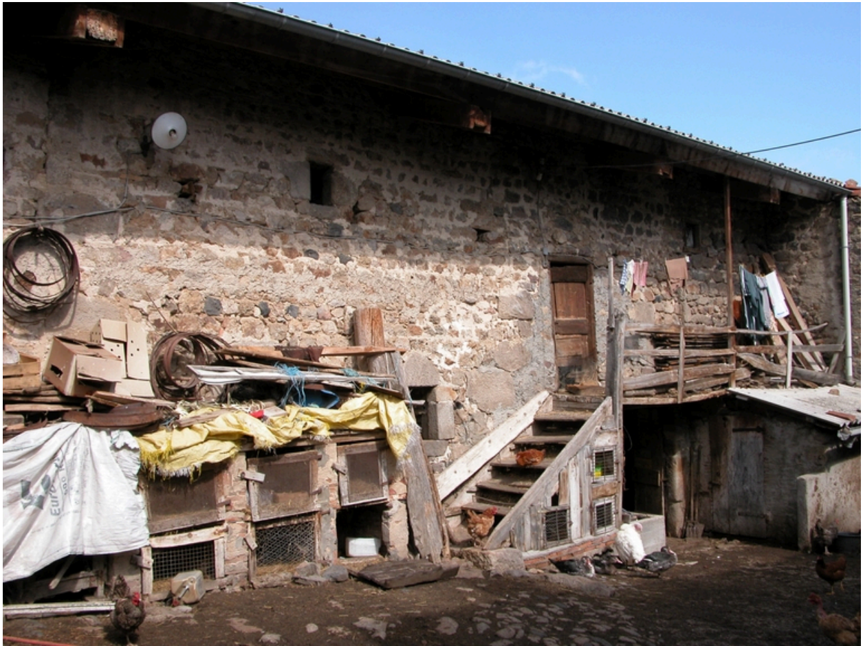
Vue de la grange-étable, depuis la cour.
