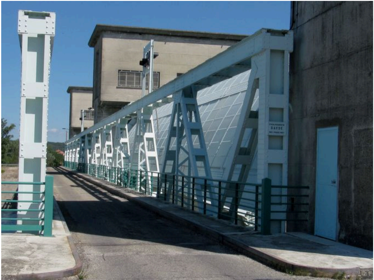
Barrage aval : chaussée du pont routier
