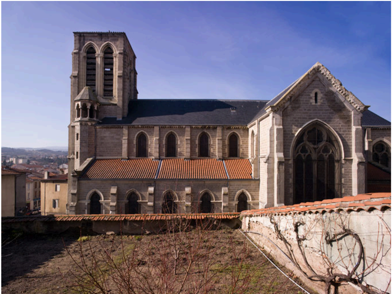
Vue partielle de l'élévation latérale droite depuis le jardin en terrasse du presbytère Saint-Pierre
