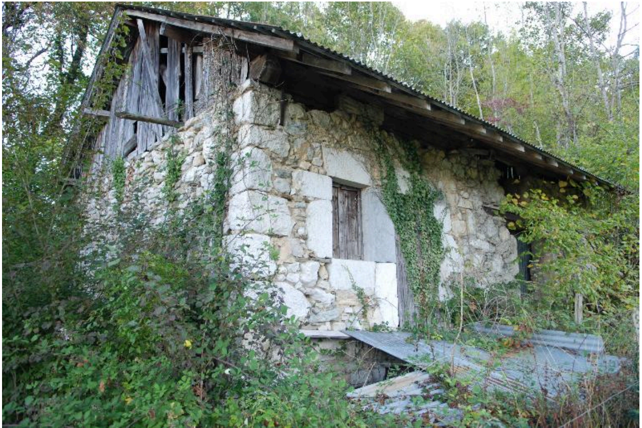
Malatret, ferme, 2014 B3 339. Vue d'ensemble de trois-quarts.
