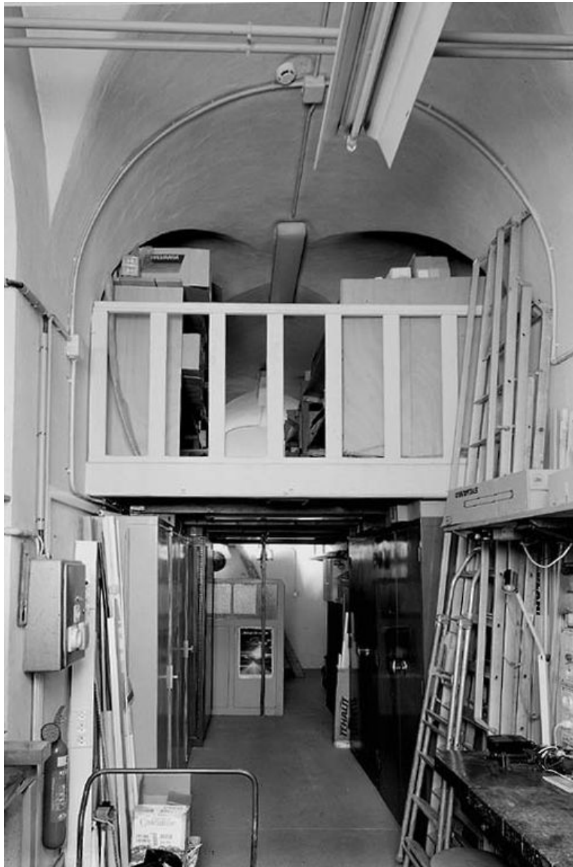
Bâtiment de la Buanderie (26), étage de soubassement, dernière pièce à l'est
