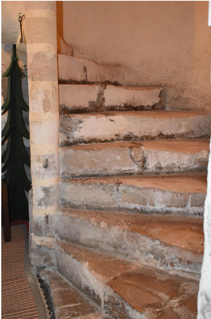
Vue de détail de l'escalier (tour d'escalier).
