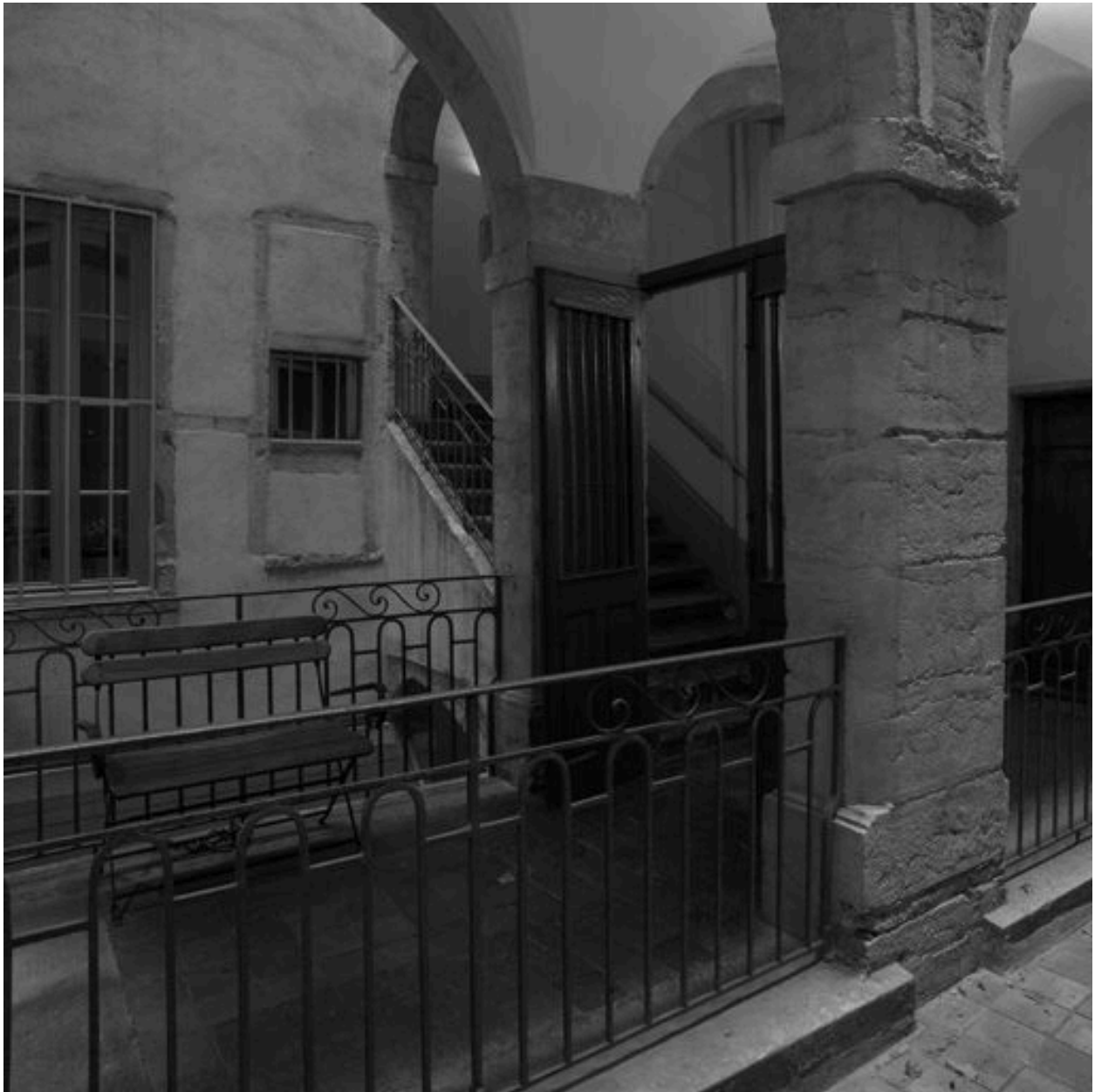
1ère cour et escalier vus depuis la 2e cour, à hauteur du 1er étage
