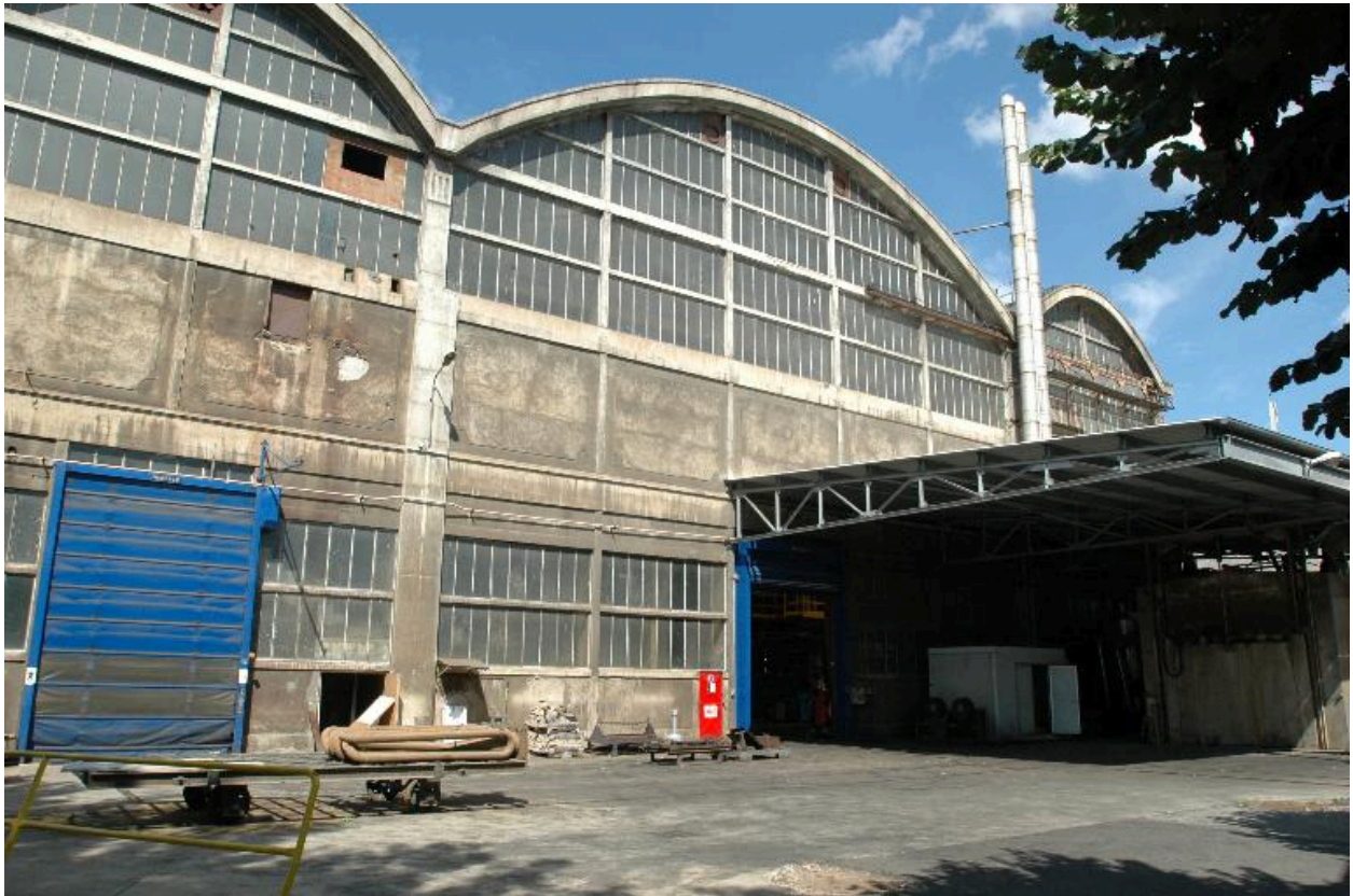
Vue extérieure des double halles
