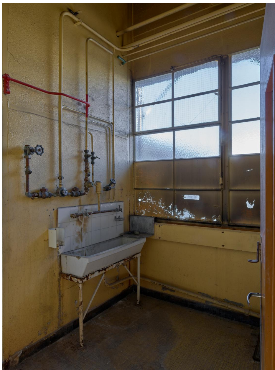
Détail intérieur du bâtiment G12, désaffecté.
