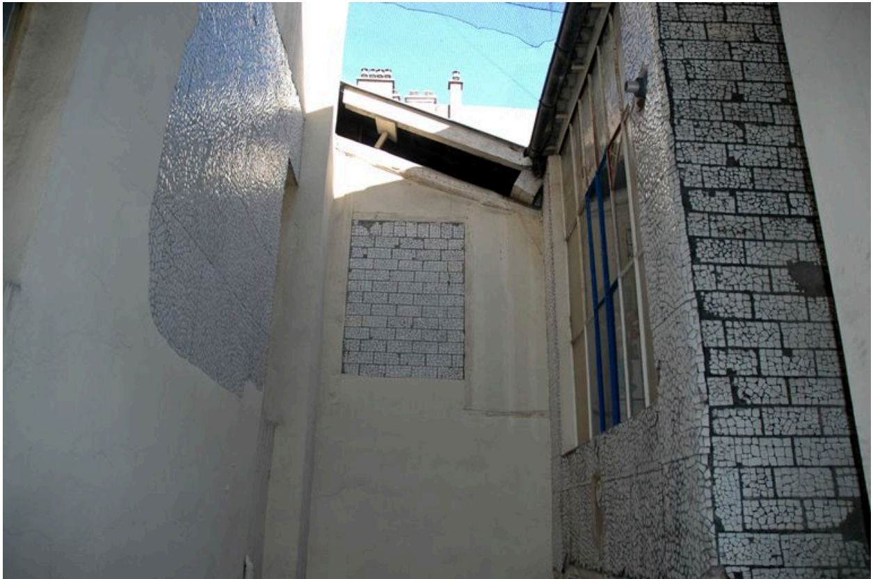
Petite cour située à l'ouest de la cage d'escalier du 105 grande rue de la Guillotière : vestiges des céramiques de l'établissement de bains
