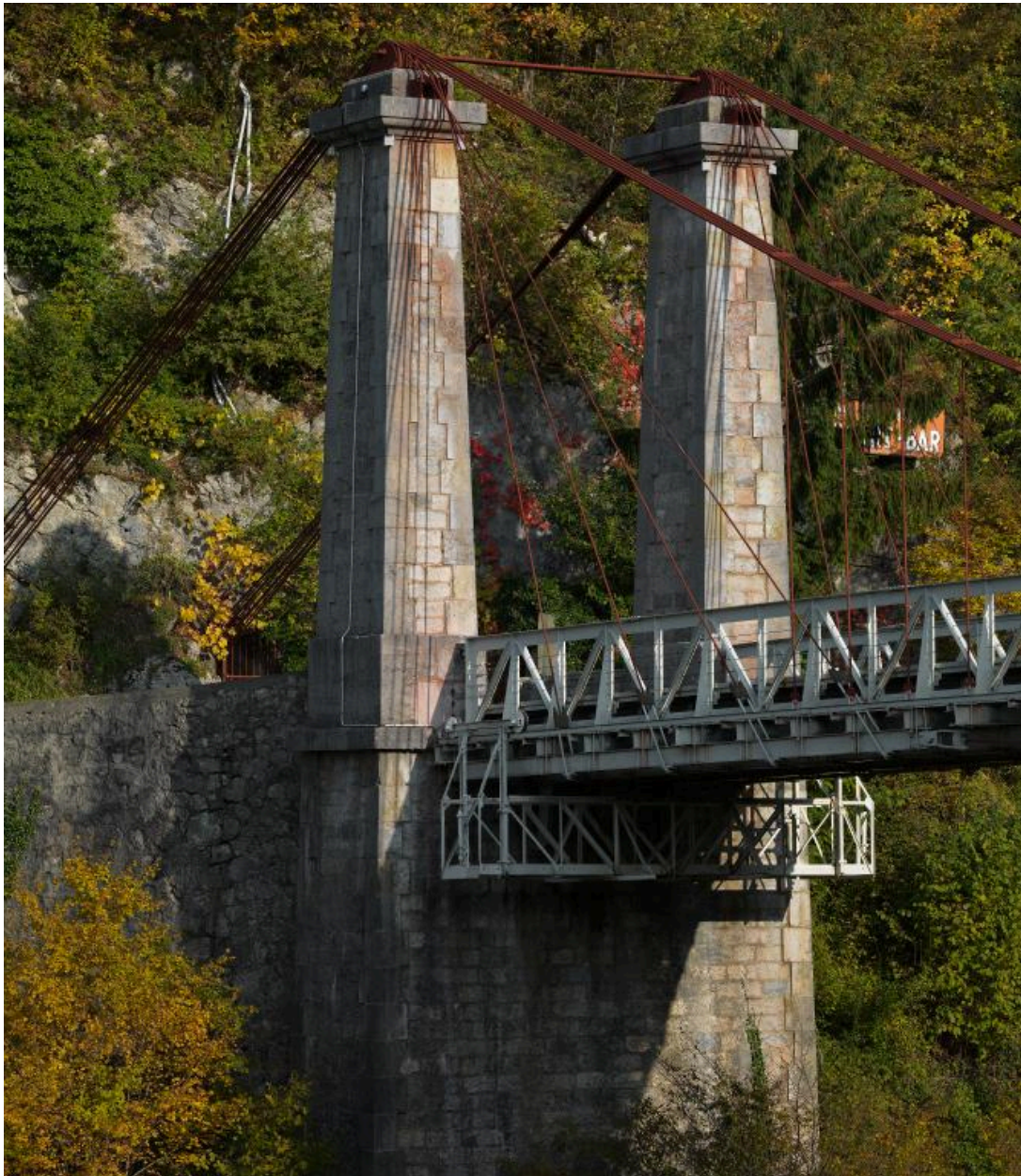
Vue d'ensemble des deux piliers du pont, côté Gruffy.
