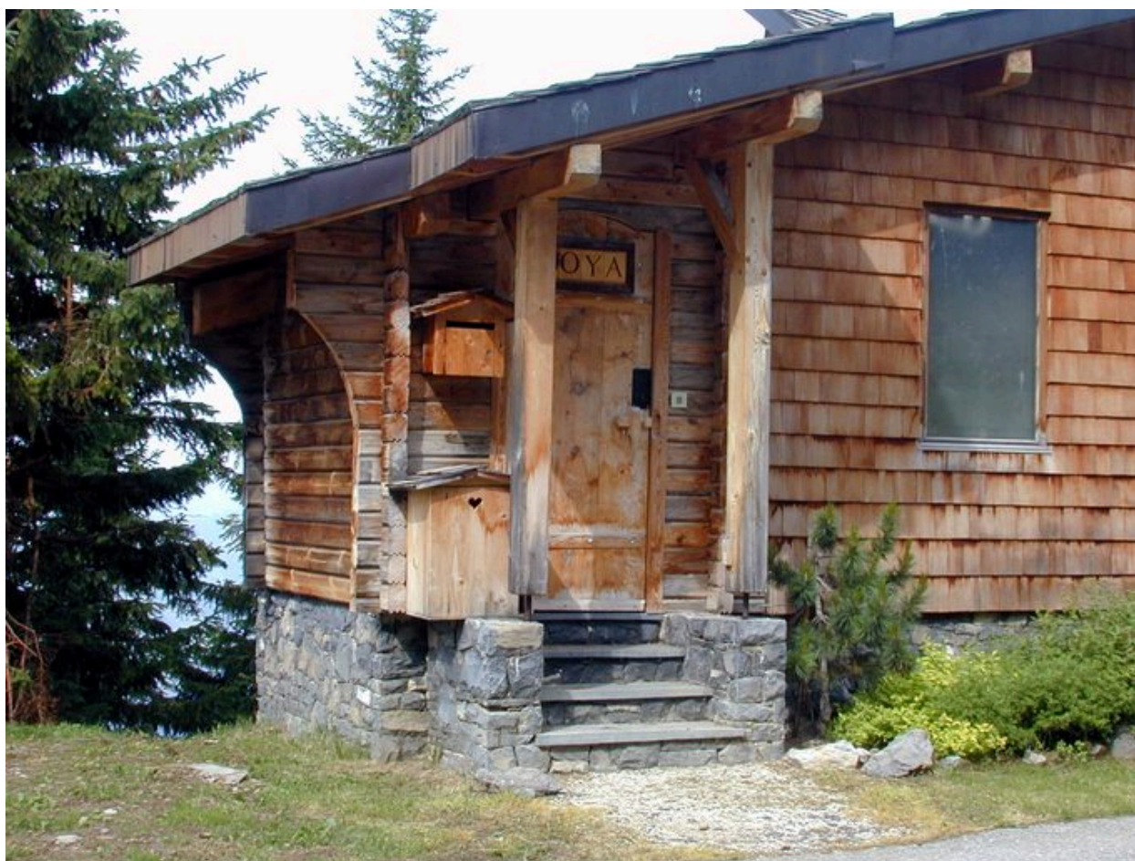
Détail de l'entrée
