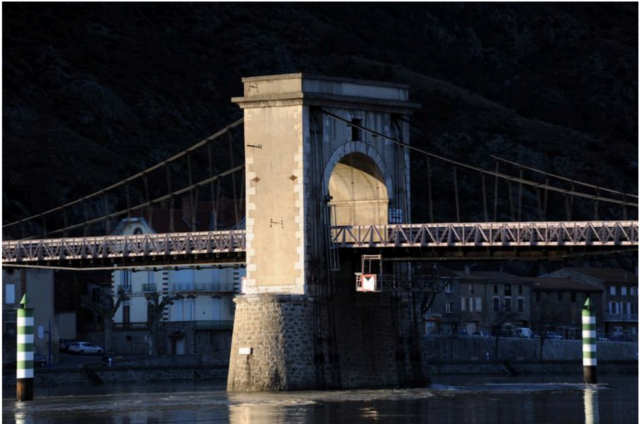
Pile centrale, face aval, vue générale (depuis la rive gauche)
