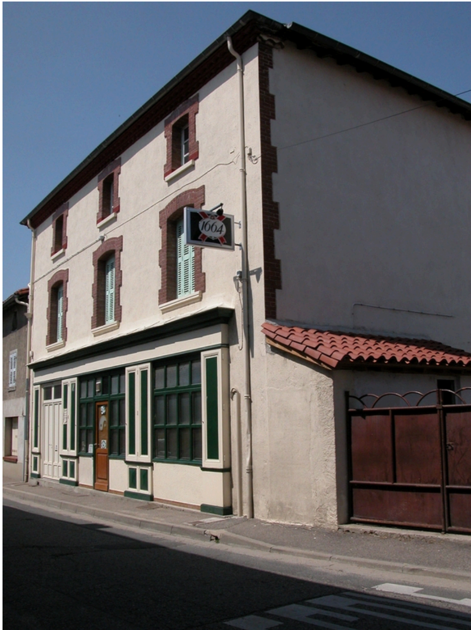
Faubourg du Chauffour. Café (1999 AB 35, rue de la Mairie).
