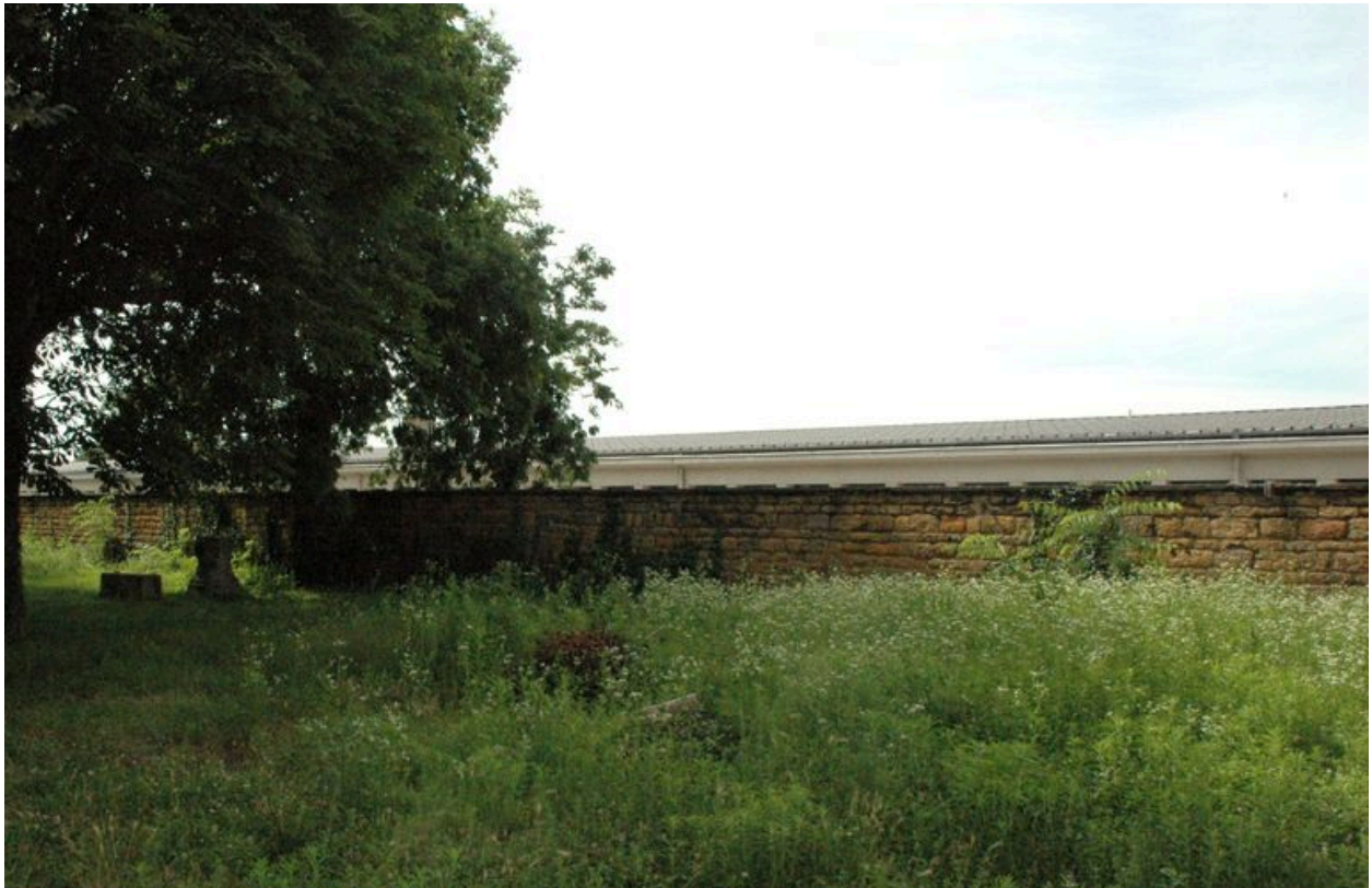
Mur de clôture sud ouest, depuis la cour du gymnase
