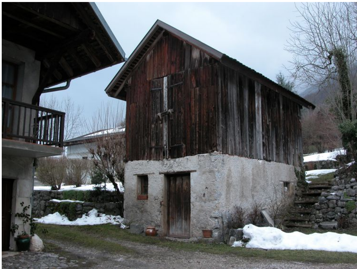
Vue générale de la maison du cheval
