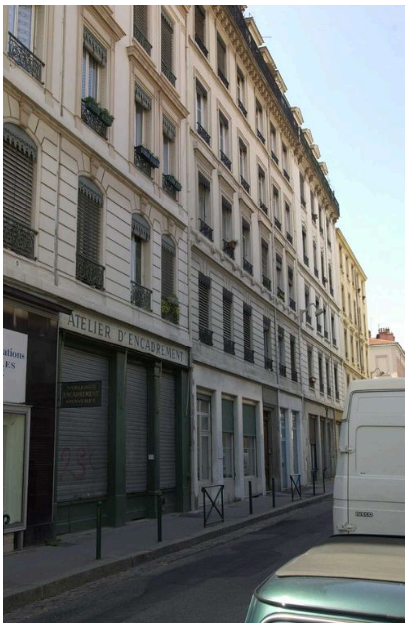
Rue Chalopin : alignement depuis la grande rue de la Guillotière
